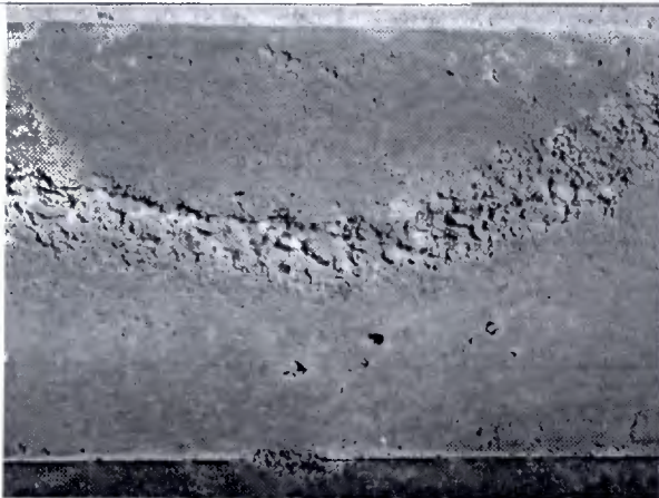
Fotografía 35: Segregación de hormigón.
