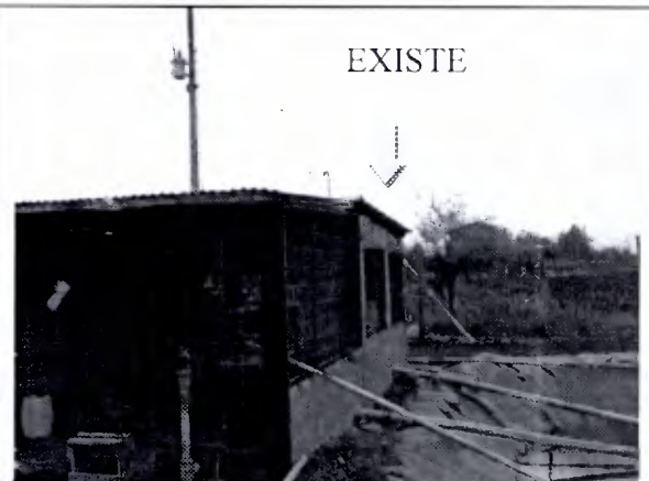
Fotografía 14: Caseta anexa a obra existente.
