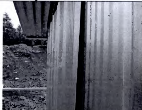
Fotografía 28: Zinc mal afianzado.
