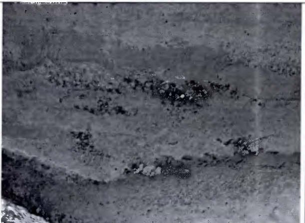
Fotografía 36: Segregación de hormigón.
