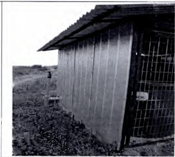
Fotografía 26: Sala de bombas.
