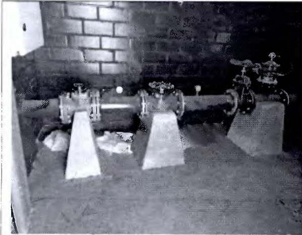
Fotografía 31: Machones de hormigón contruidos.
