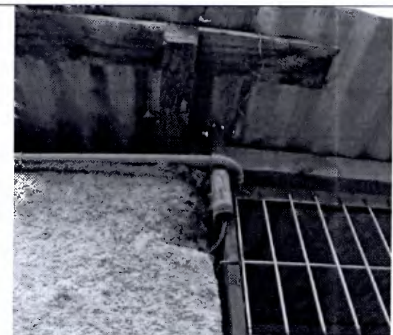
Fotografía 18: Daños no reparados.
