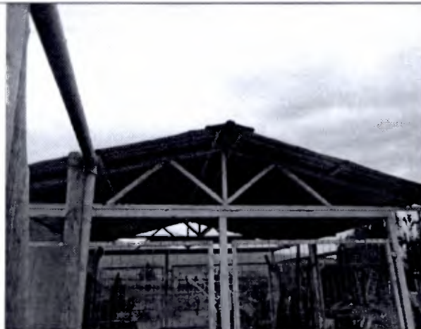
Fotografía 11: Construcción con presencia de óxido.
