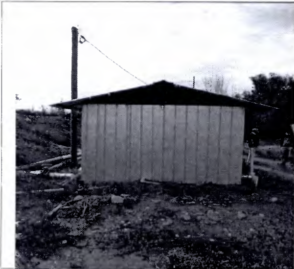
Fotografía 25: Sala de bombas.
