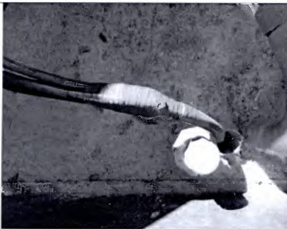
Fotografía 27: Perfiles de dimensión inferior a la recomendada.
