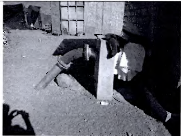
Fotografía 32: Machones de hormigón contruidos.
